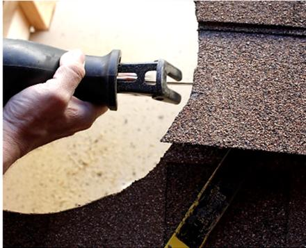
**TIP: FLASHING BASE SHOULD SLIDE UNDER TOP SHINGLES, AND OVER BOTTOM SHINGLES.**
